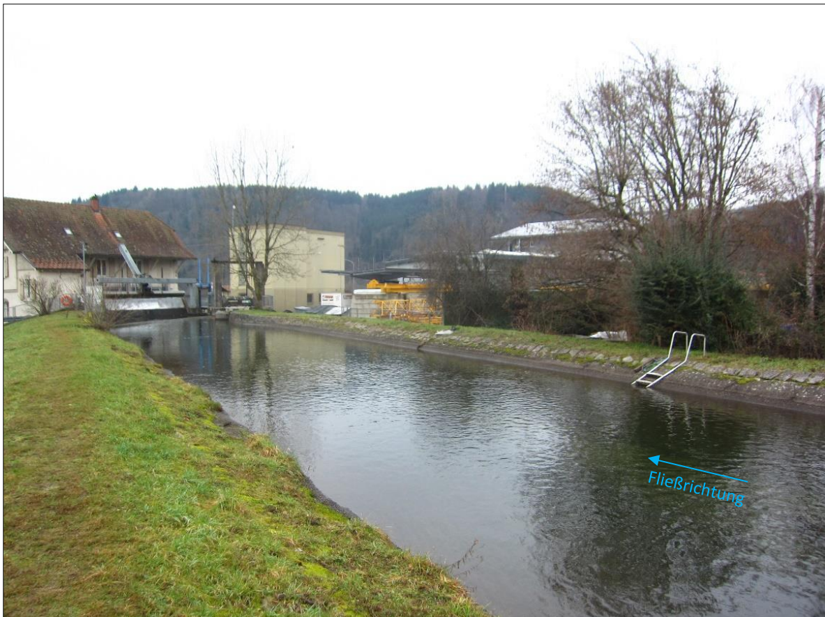
Abb. 3: An das Plangebiet angrenzender Gewerbekanal und dem Kleinwasserkraftwerk Gündenhausen.
