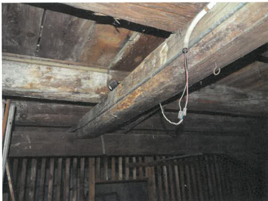
Bild Nr.05 ff (starker Hausbockbefall an den Knotenpunkten.
