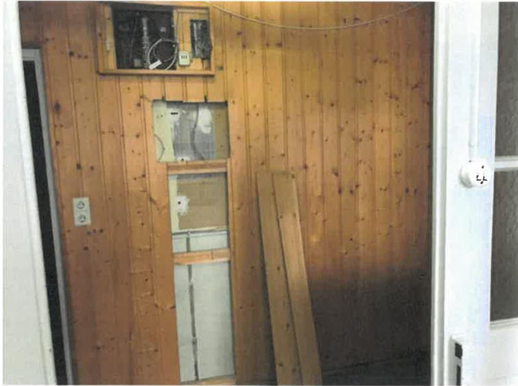
**Bild Nr.24 ff Raum B106 Verkleidung mit Nut & Federbretter**
