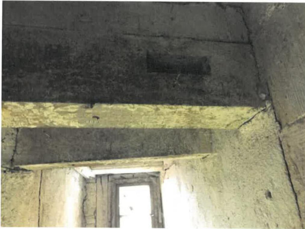
**Bild Nr.33ff Keller unter Flurbereich - nachträglich eingebaute Neuhölzer zur statischen
