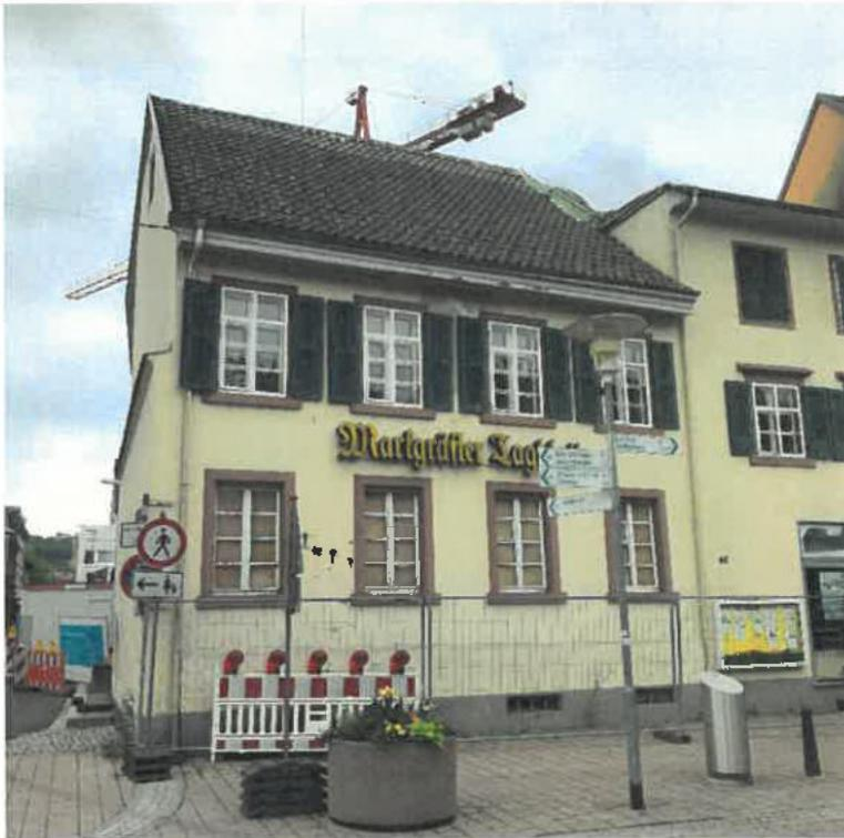
Bild Nr.00ff Außenansicht Hauptstraße 40 – Feuchteschaden am Dachgesims, fehlende Brandwand Haus A und Neueindeckung am Firstbereich
