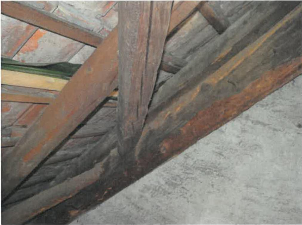
**Bild Nr.03 ff (Achse/ Schnitt B-B Dachspitz) – Firstanschlusspunkt Zustand gut**
