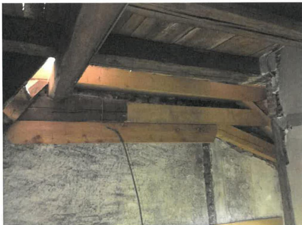
**Bild Nr.04 ff Achse/ Schnitt B-B - 1.Dachgeschoss – Strebewerk mit Neuhölzer**
