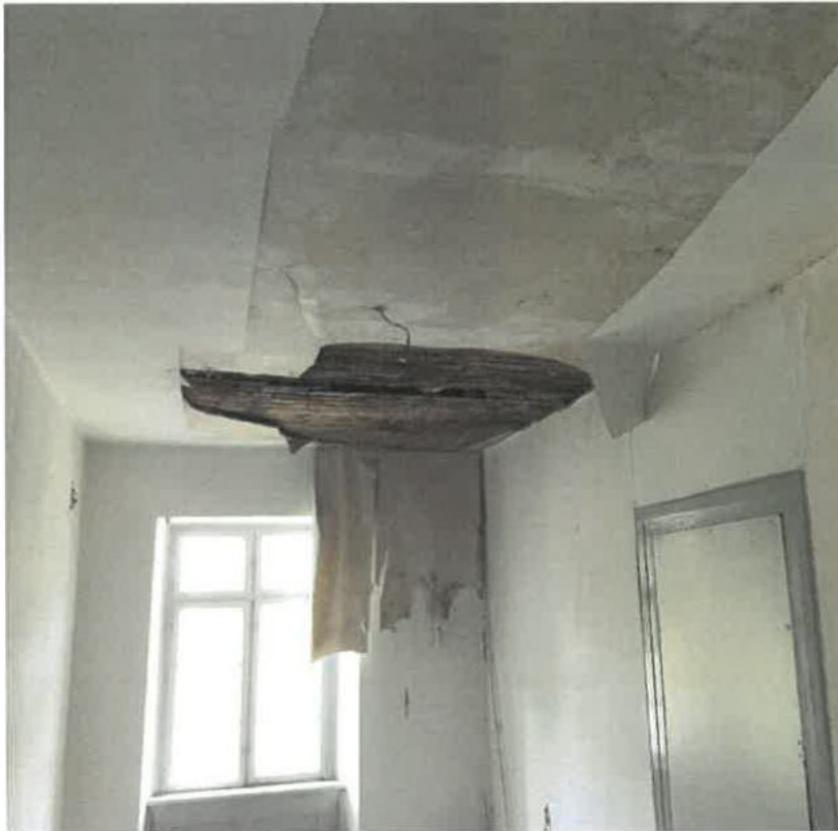
**Bild Nr.06 ff (Deckenöffnung 01 - Deckenbalken stark vom Hausbockbefall beschädigt, die untere Hälfte der Tragbalken ist stark befallen, Tragfähigkeit der Balken nicht mehr gegeben.)**
