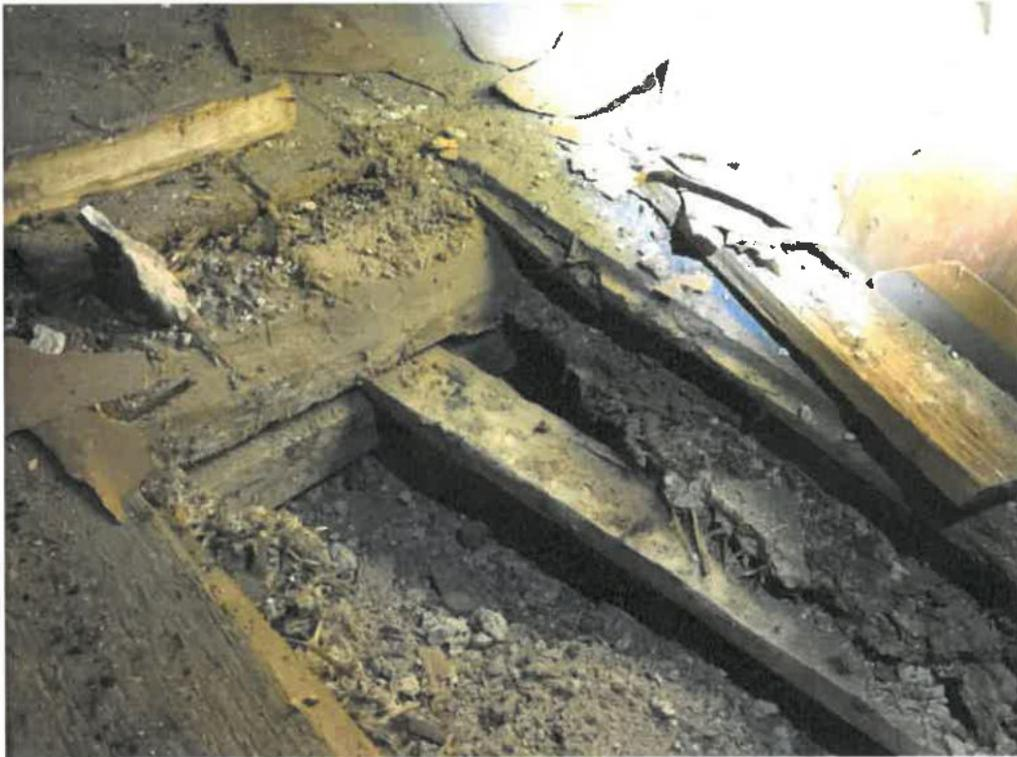
**Bild Nr.05d ff Achse/ Schnitt C-C - 1.Dachgeschoss – Strebewerk zur Straße in einem gutem Zustand erhalten.**
