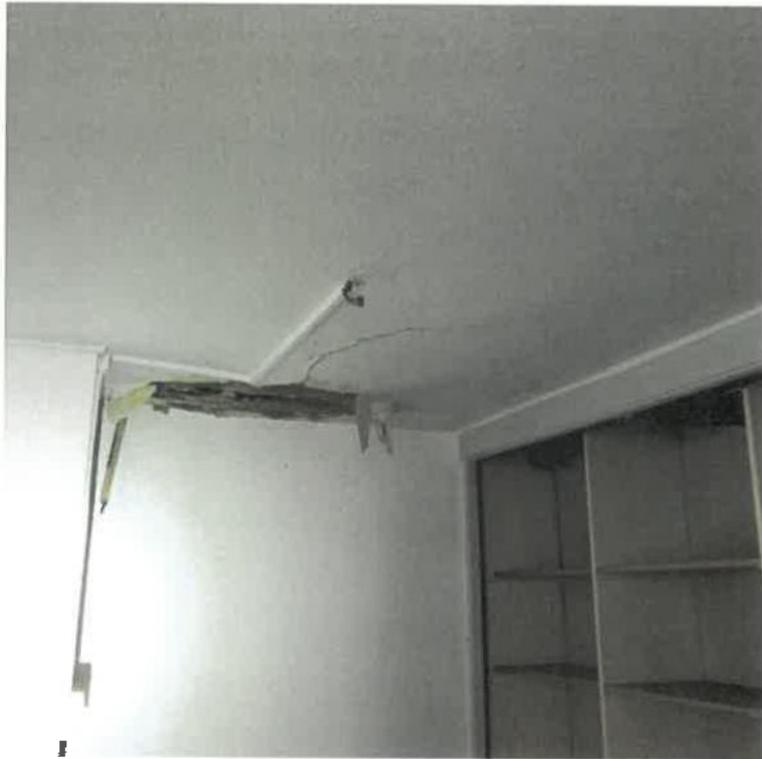
**Bild Nr.17 ff (Deckenöffnung 05 - Decke EG – Raum B106 leichter, beginnender Hausbockbefall an der Unterseite der Holzbalken)**
