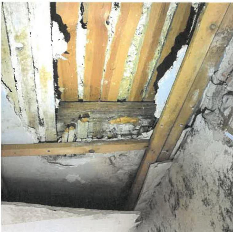
**Bild Nr.08 – Raum B214, Innenseite an der Außenwand, starke Schimmelbildung**
