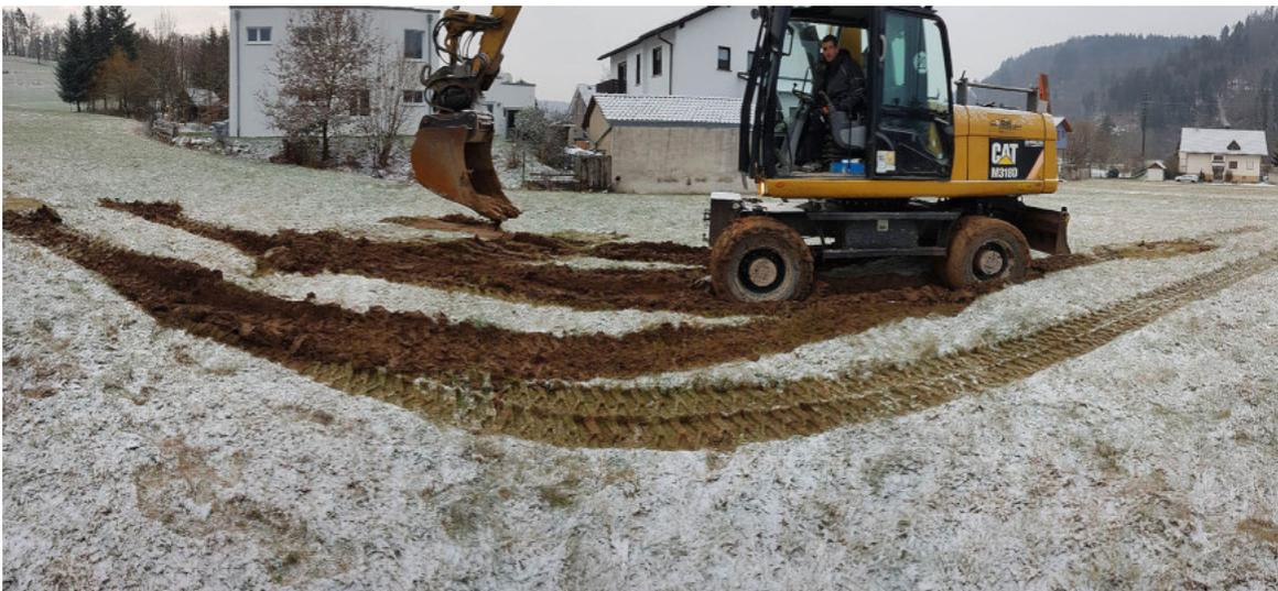
Bild 4 : Gelände am 23.01.2019; der Bagger blieb in dem weichen Untergrund stecken
