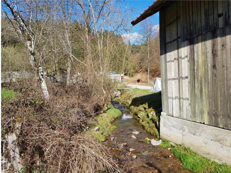
**Abbildung 3:** Ufer im Bild rechts verbaut mit Steinsatz bzw. Betonmauer; am gegenüberliegenden Ufer schmaler Galeriewaldsaum
