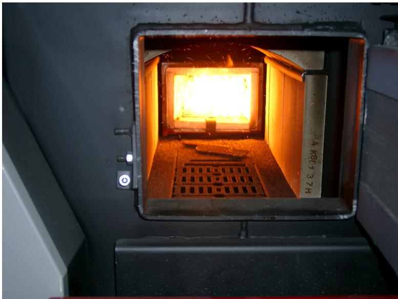
Seit dem 11. September 2007 wird jedenfalls die Grund- und Hauptschule und Bergkopfhalle in Gersbach mit Holzpellets beheizt. Diese Anlage bietet zusätzlich auch die Möglichkeit, mit Stückholz oder auch mit Hackschnitzel befeuert zu werden. Damit ist man flexibler gegenüber Veränderungen und kann auch eventuelle Lieferengpässe ausgleichen.
