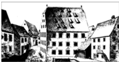
Nordseite des Kornhauses (heutige Hebelschule)
