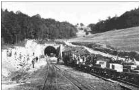
Bau der Bahnlinie Schopfheim - Säckingen beim Tunnel Fahrnau
